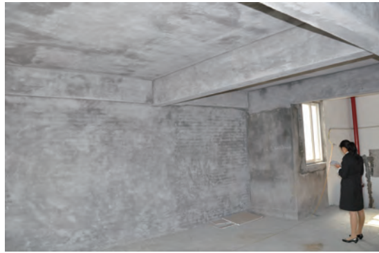
图 2-4 现场测量和尺寸记录 2
