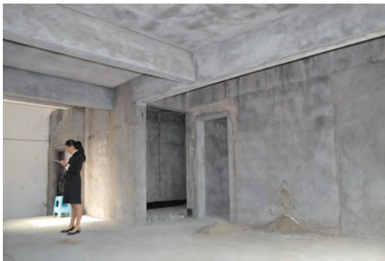
图 2-3 现场测量和尺寸记录 1
