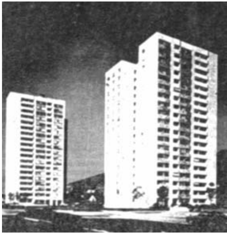
图 4 采用砌体承重墙建于瑞士的高层房屋
